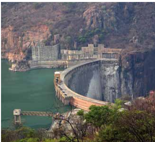
Figure 5.23. Barrage de Cahora Bassa sur le principal chenal du fleuve Zambèze en Mozambique. Après la construction du barrage en 1975, 85% des eaux du fleuve ont été régulés; ce barrage et d'autres dans le bassin du Zambèze ont des répercussions importantes sur le fonctionnement naturel du bassin du fleuve. Le Cahora Bassa, en particulier, a entraîné des changements importants dans le delta du Zambèze (source : Carlos Bento).
